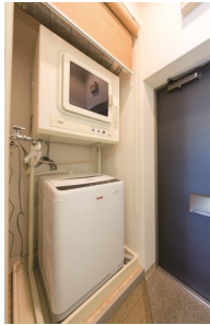
洗濯機と乾燥機
